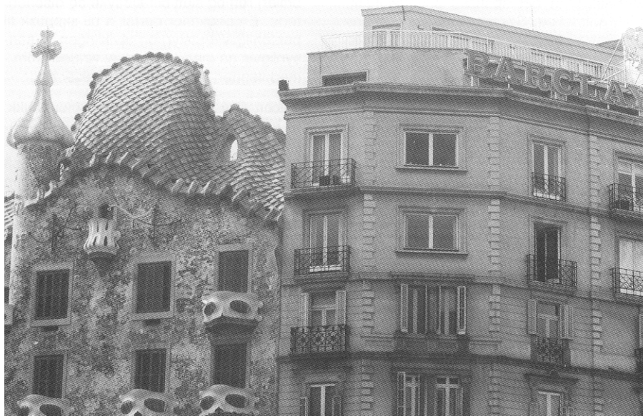
En av arkitekten Gaudis mest kjente bygninger, Villa Batlo, plassert i en helt vanlig husrekke, i en helt vanlig gate.
